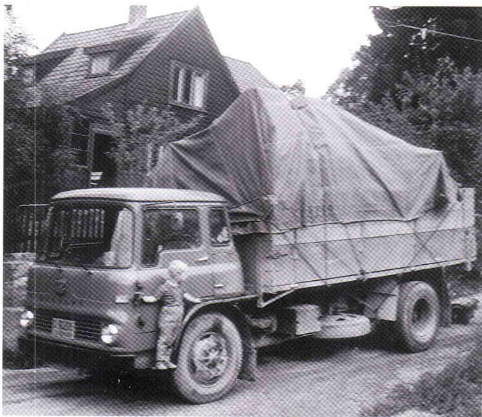
Willy Karlsens lastebil med flyttelasset vårt i det vi flytter fra Skoleveien 24, Fjellstrand i 1961.
